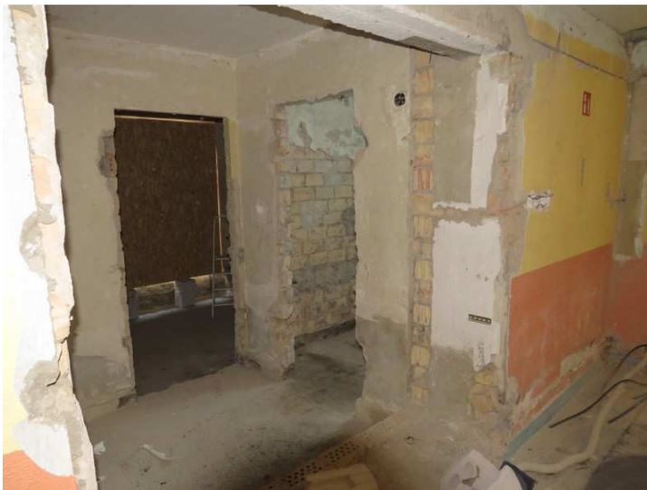
alter Elektrokasten entfernt
