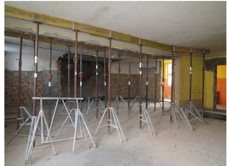
neuer Kraftraum mit Durchbruch zur ehem. Sauna
