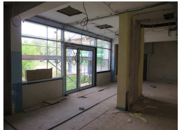
Eingangsbereich mit neuen Fensterelementen
