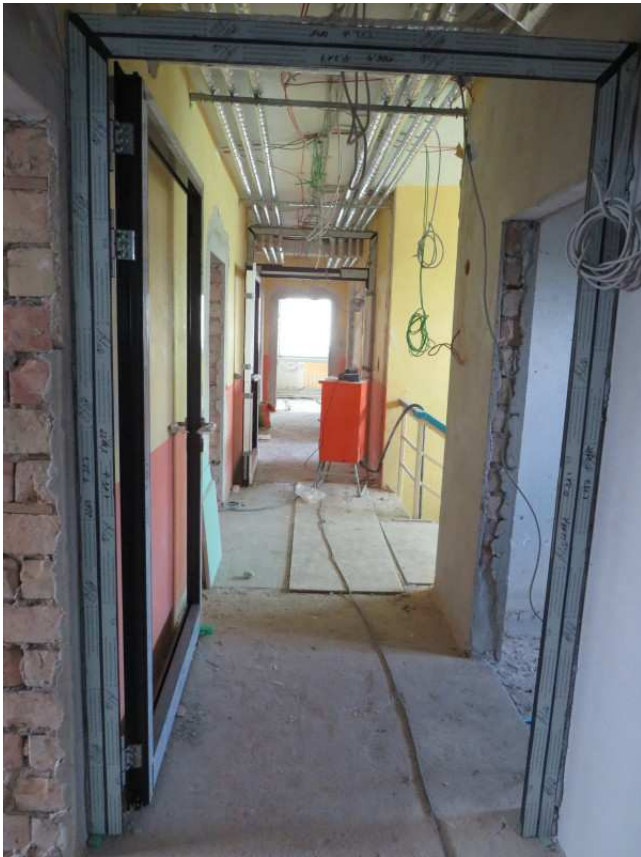
Flur im OG
