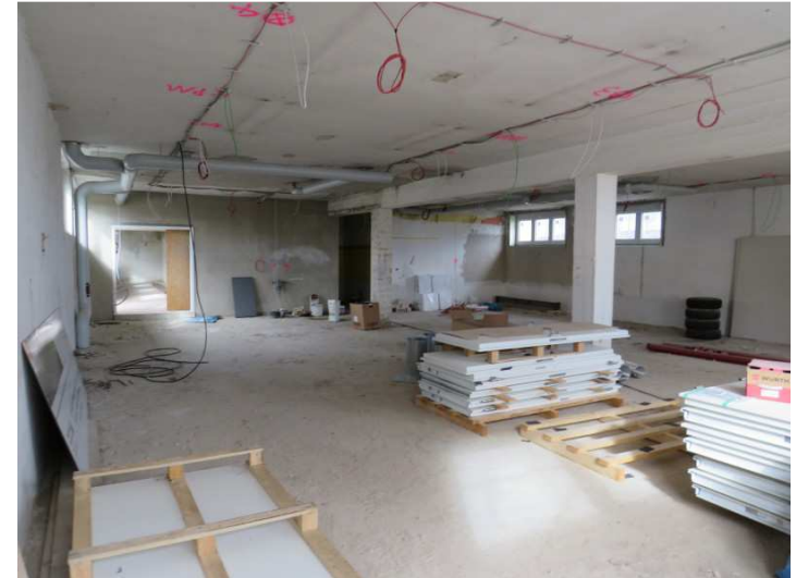
Bootshalle und Durchgang zur Werkstatt
