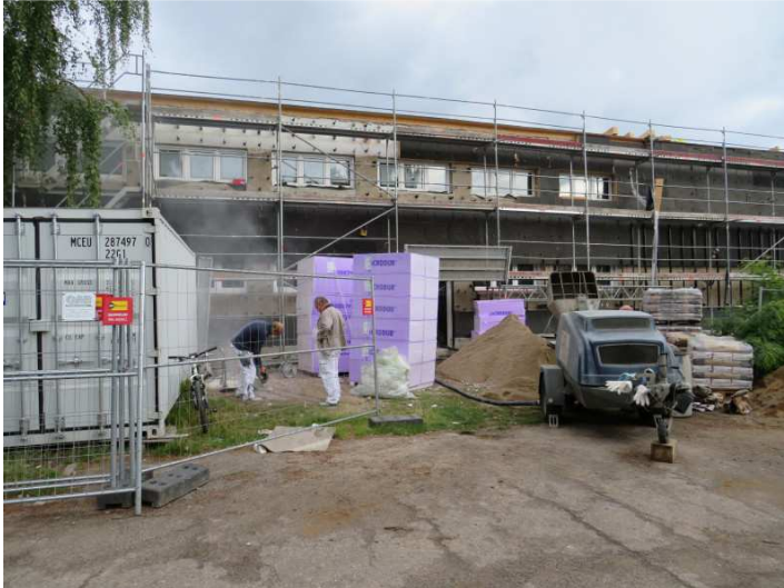
Estricharbeiten im Bootshaus
